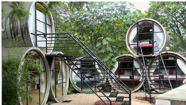
ചിത്രം 30: RCC Pipehouse 2
