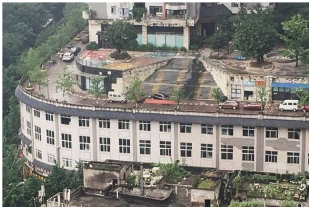
ചിത്രം 16: Road on Terrace
